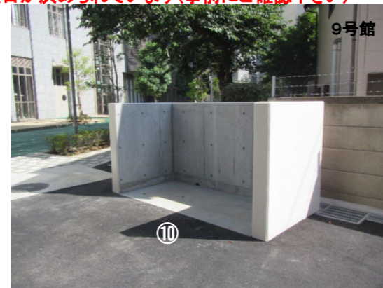
9号館 コンクリート類
